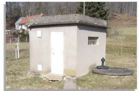
Captage d'alimentation en eau potable
