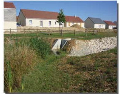
Réseau d'évacuation des eaux pluviales
