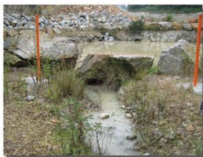
Eaux de ruissellement canalisées
