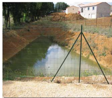
Bassin de stockage et d'infiltration
