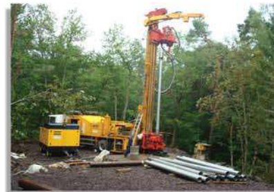
Phases de travaux
